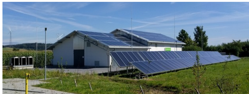
GDR A Ostheim, 421 m 2 Solarkollektoren und 120 kW Gas-WP, 2016
